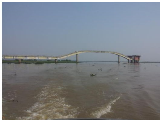
Toma de agua, ciudad de Corumbá
