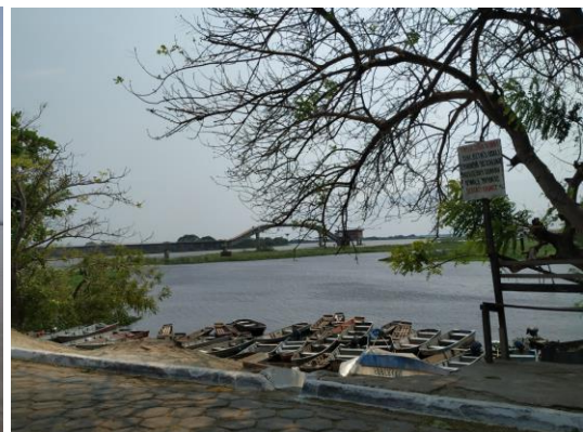
Toma de agua, vista desde la ribera
